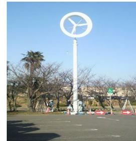
風レンズとは、風車に取り付けて、風力を効率よく獲得するための部品であり、つば付きディフューザと表現されることもあります。風レンズを装着した風車を「風レンズ風車」、「レンズ風車」または「つば付きディフューザ風車」などと呼ばれますが、九州大学によって開発されました。風レンズ風車の利点としては以下のものが挙げられています。
